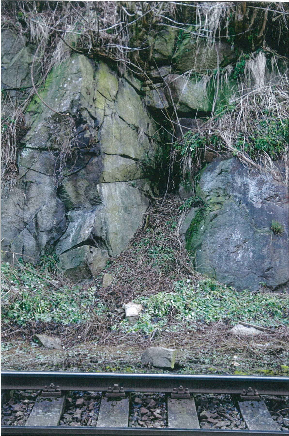
Foto – 11 Pohled vpravo v km 300,890 na vypadlé fragmenty ze svahu (stěny) odkryvu.
