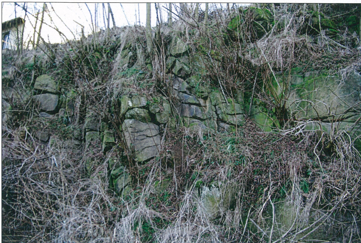
Foto – 7 Detailní pohled v km 300,860 na rozvolněnou horninu (žula) v odkryvu.
